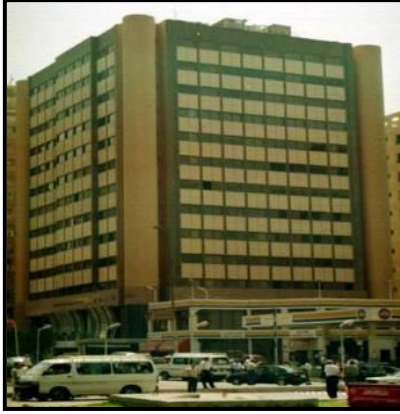
شكل رقم (٧٤): التأثير البصري للحواف الناعمة - مبنى البنك الأمريكي - مدينة نصر - القاهرة.
