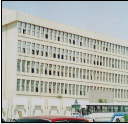
شكل رقم (١٣٨): الإحساس بالملل والرتابة في التشكيل البصري نتيجة لتكرار النوافذ وكاسرات الشمس الراسية حيث التطابق في الشكل والحجم - مبنى إداري - القاهرة
