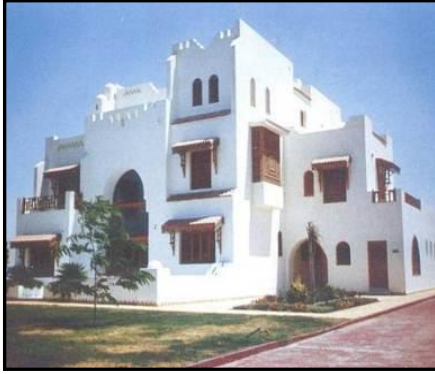
شكل رقم (٩٥): استخدام البياض والخشب في أعمال النهو والتكوين (إحساس بالخفة) - مسكن خاص - القاهرة.
